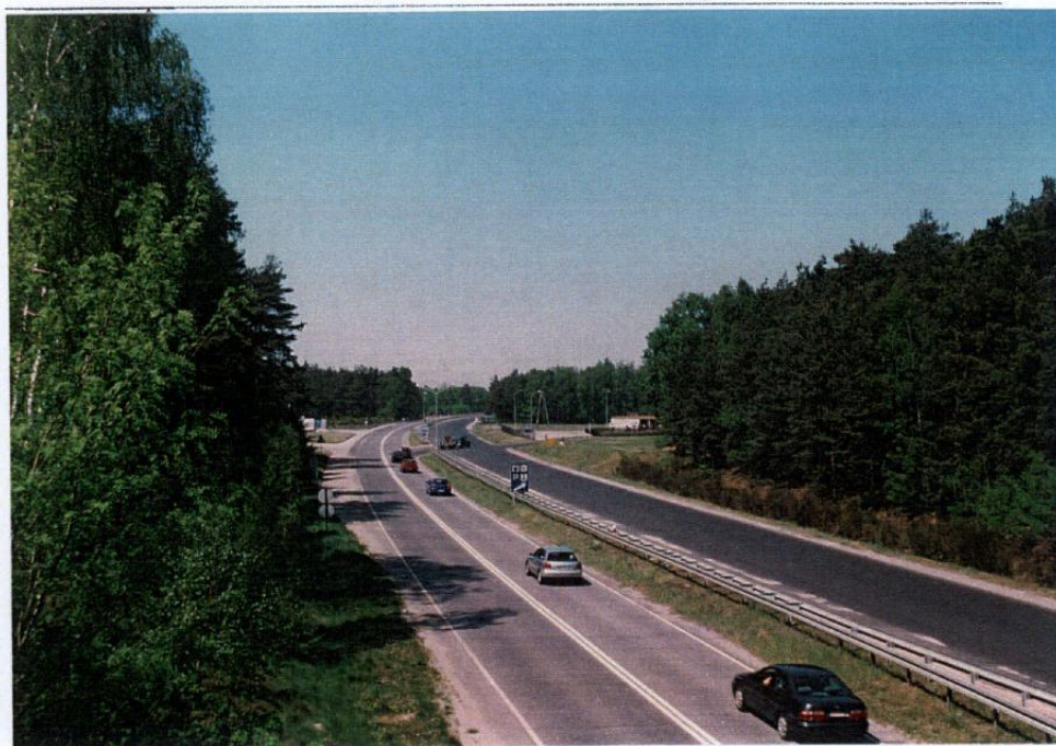
DROGA KRAJOWA NR 12 / PRZYSZŁA AUTO- STRADA w REJONIE JAGŁOWIC CZERWIEC 2000r
